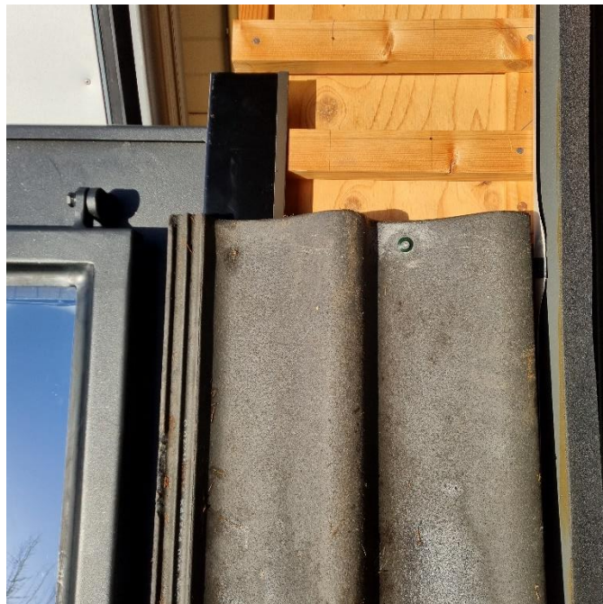
Nok van pan wordt afgeslepen en pan kan worden vastgeschroefd
